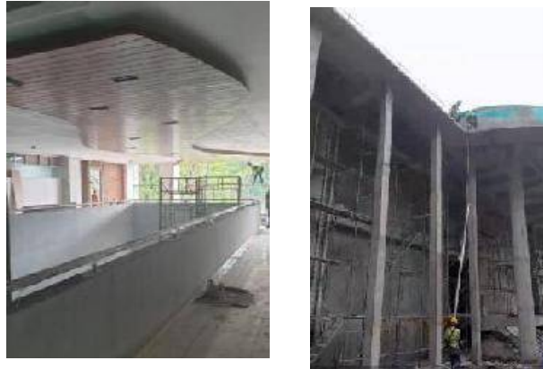
Gambar. Proses Pembangunan Gedung Pascasarjana dan Serbaguna
